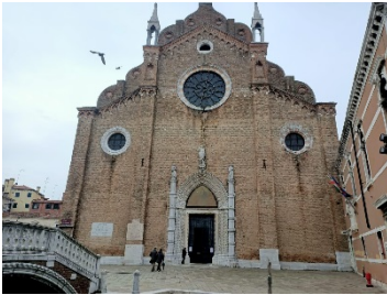
Basilica di Santa Maria Gloriosa dei Frari facciata gotica
